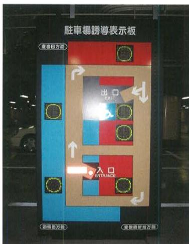
フロア内図盤表示。満空情報等をブロック単位で識別しやすく表示。
