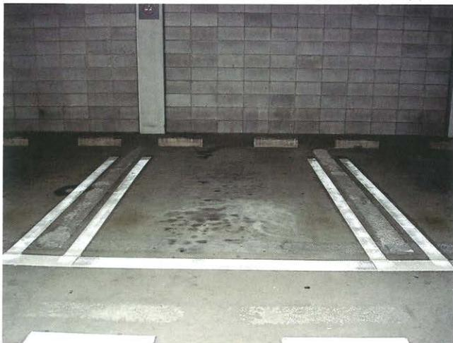
ダブルラインにした車室の側線。隣室との間にドア開閉スペースを確保。
