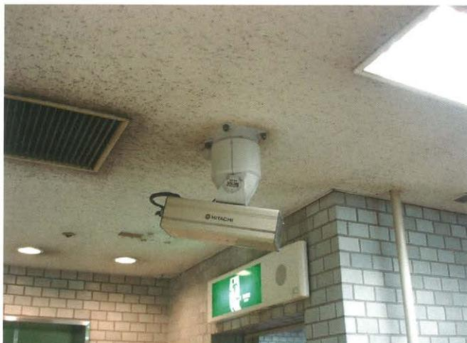
場内の要所に設置された可動式監視カメラ。死角がない配置が望まれる。
