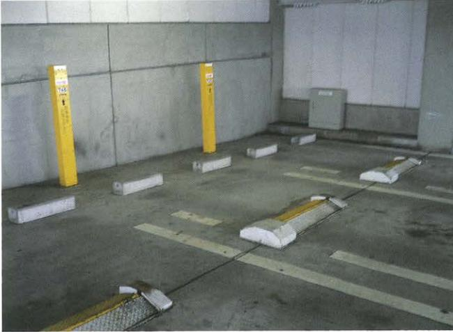
車室ごとに機械を設置し入庫・出庫処理をするゲートレスシステム。
