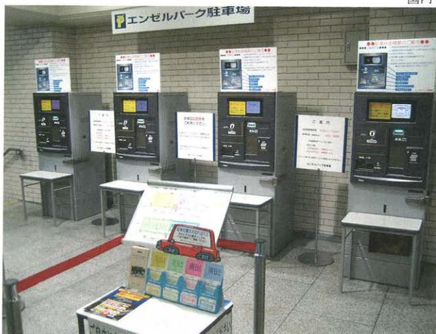
事前精算機。出口では精算済カードの挿入のみでスムーズに出庫できる。
