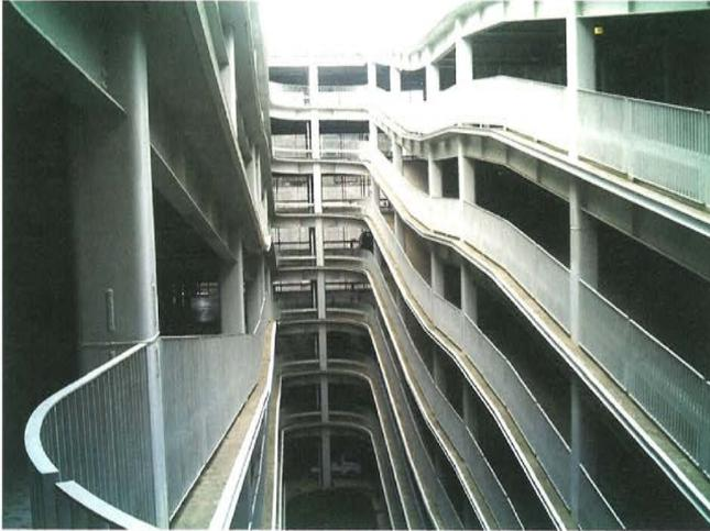
ダブルスパイラルの走行スロープ。高層階への移動には大きな能力を発揮する。
