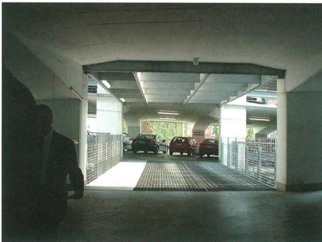
連続傾床タイプに設置された連絡通路。途中階での上り、下りの転換が可能。
