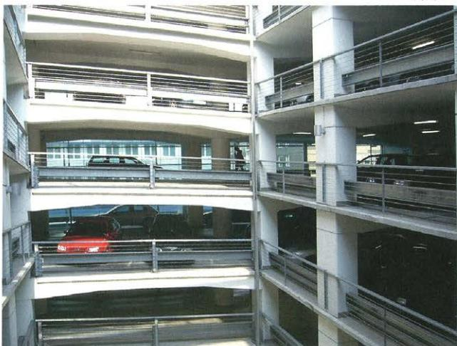
床面に傾斜をつけた連続傾床タイプ。上下階に移動しながら空室を探せる。
