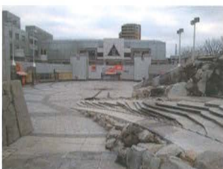
写真 ②（北から見た下層広場）
