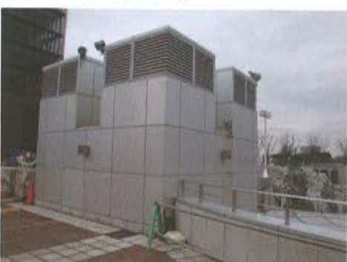
写真 ⑥（換気塔）
