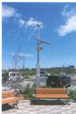
▲ハイブリッド街路灯（岩崎電気製） （越谷レイクタウン）
