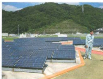
▲支柱の低い架台により設置 (三原市水道局)
