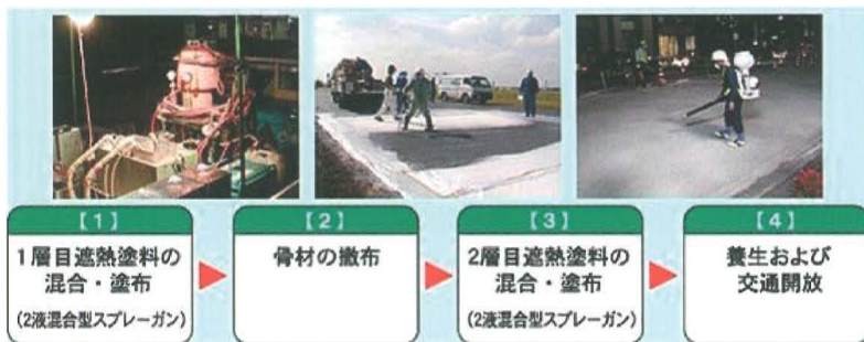
図 50 遮熱性舗装施工手順
