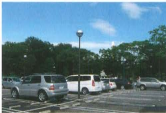
▲照明灯（平面駐車場）
