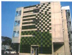
写真 1 施工例 (大阪大学 FRC 研究棟)
