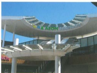
▲壁面設置された太陽光パネル (越谷レイクタウン)
