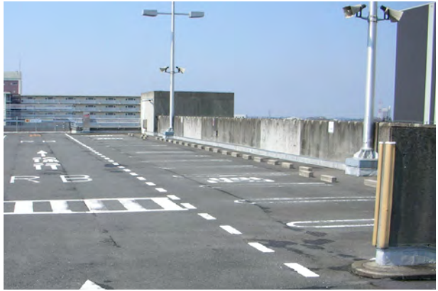
R 階壁面の案内表示（北棟）
