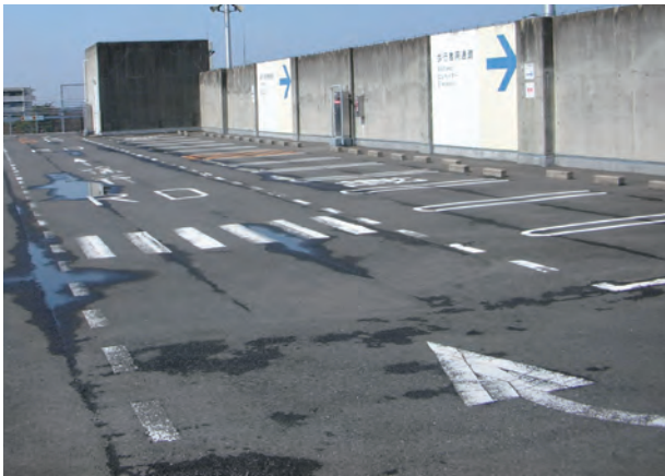
R 階壁面の案内表示（南棟）
