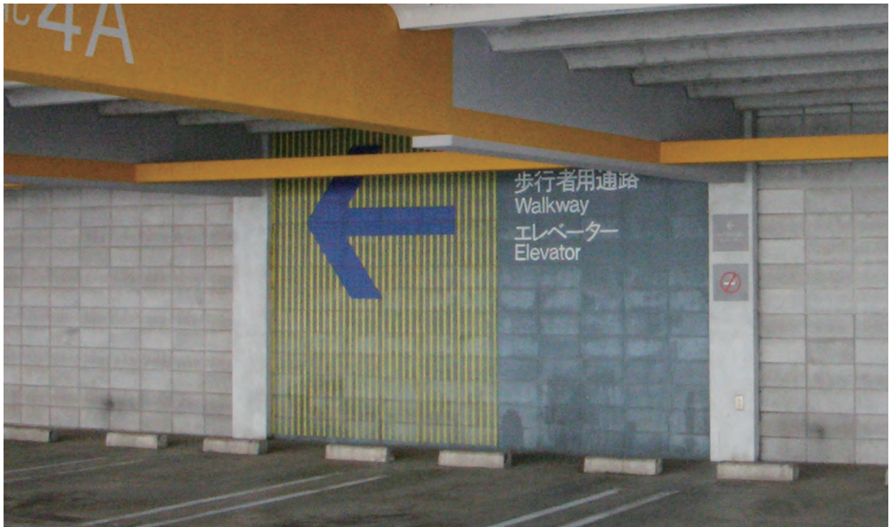
車室壁面（北棟 4A）
