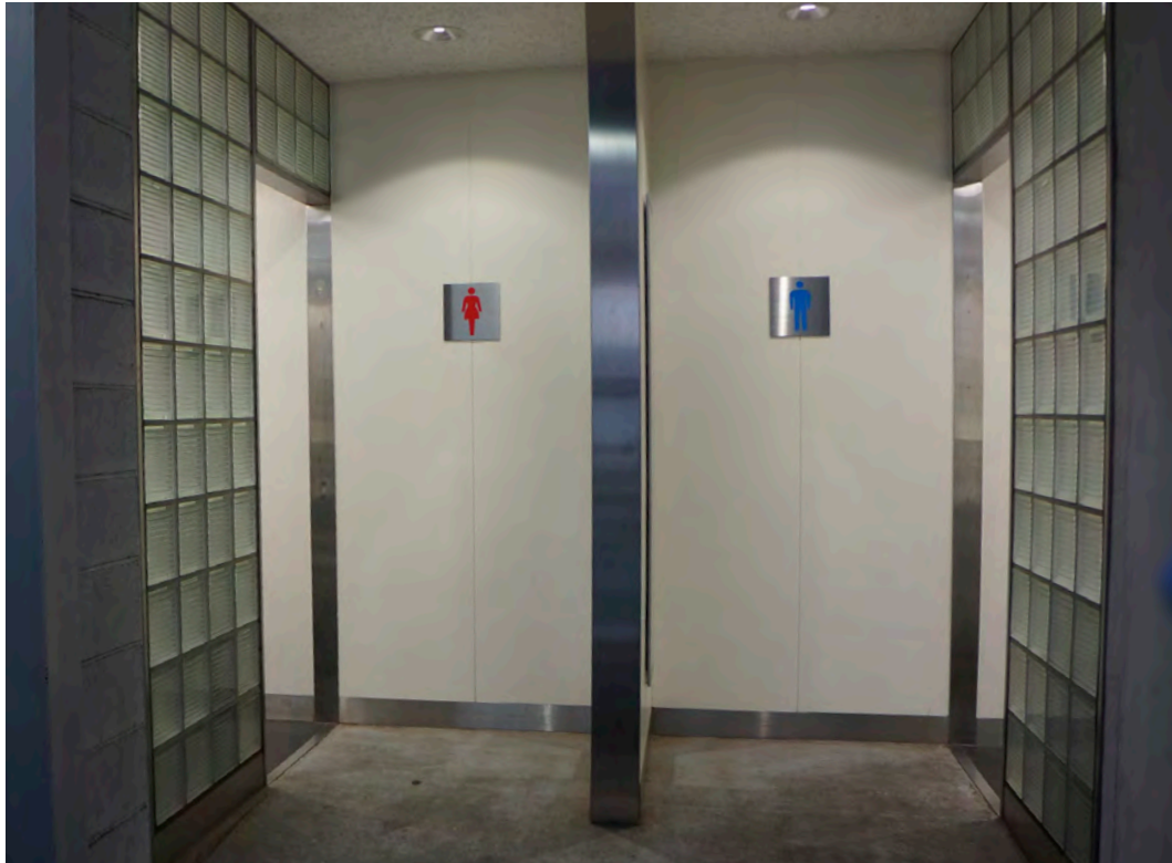
施工後トイレ（入り口）
