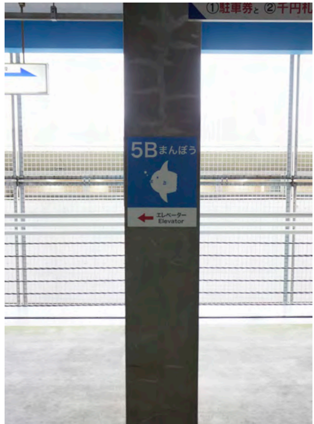
車室柱表示 (うみの棟 5B)
