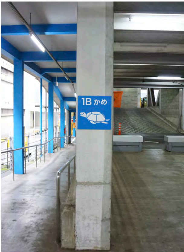
車室柱表示 (うみの棟 1B)
