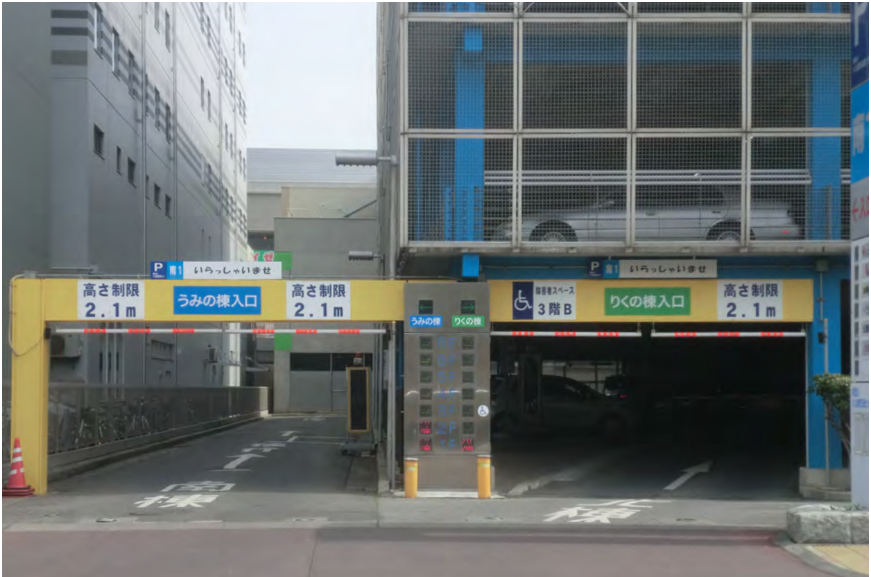
「りくの棟」「うみの棟」入り口看板施工後
