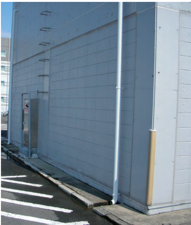
R階エレベーターホール外側
