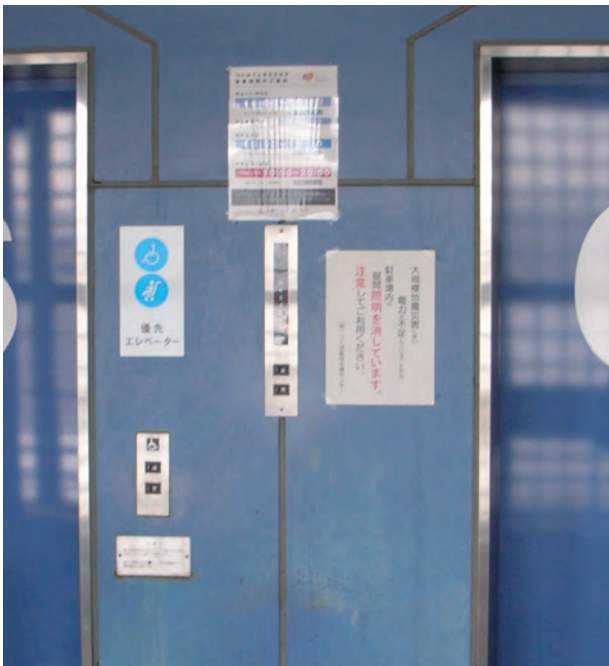
エレベーターホール 案内表示 (6F)
