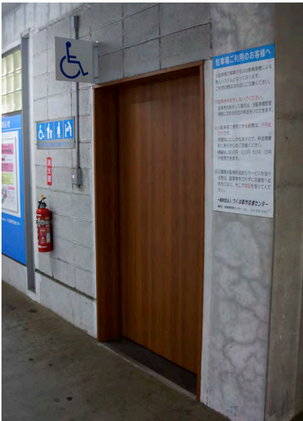
「みんなのトイレ」施工後（入り口）
