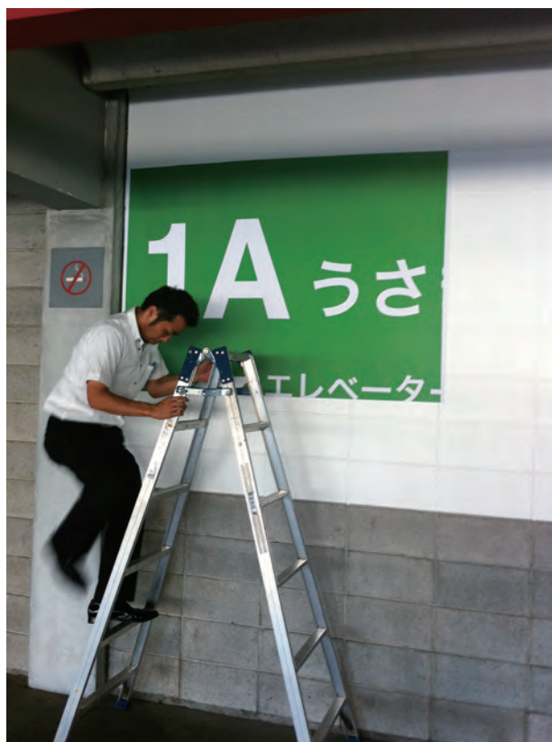
車室内壁面サイン表示の現場合わせ
