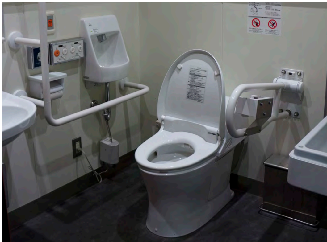
「みんなのトイレ」施工後（内部）
