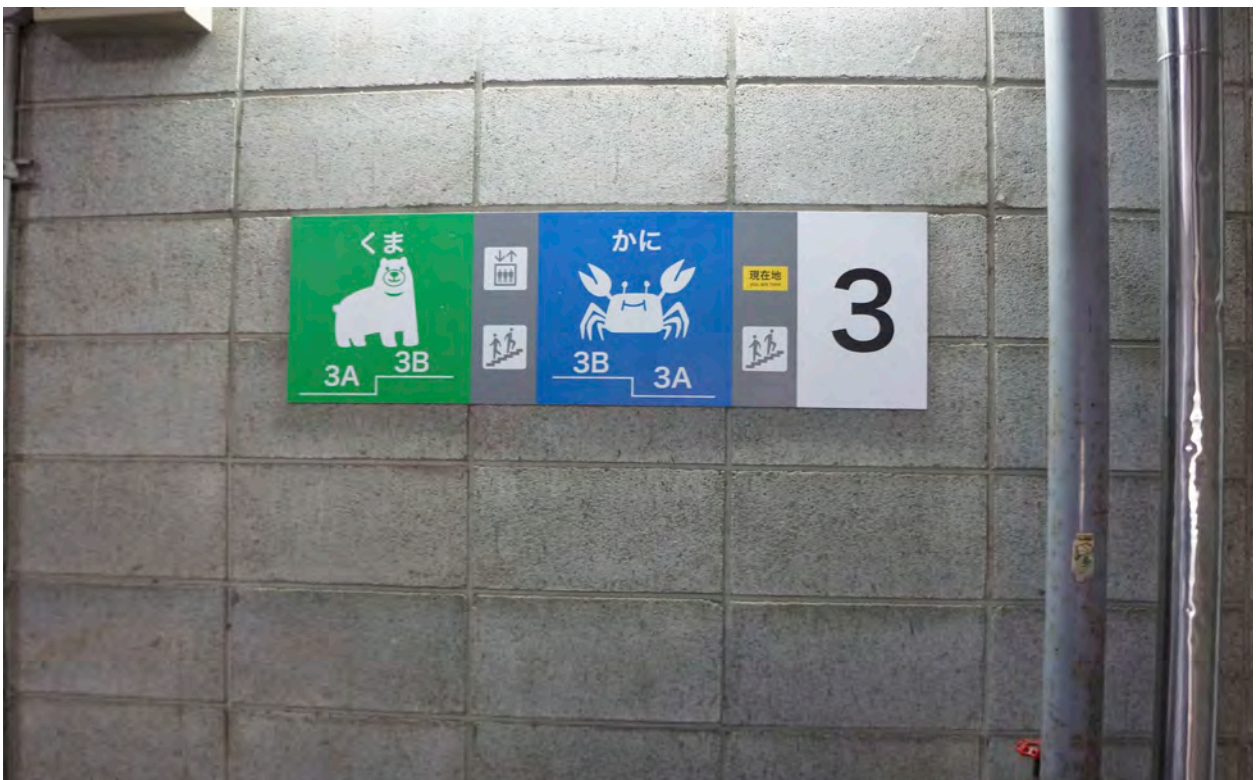
通路表示施工後 (3F)
