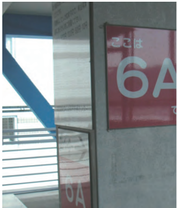
柱表示と通路内柱塗装色の混在（南棟 6F）
