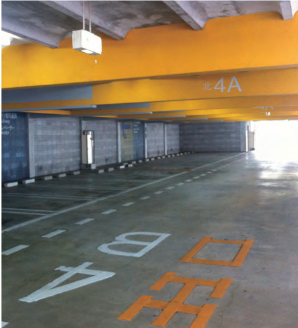
駐車場車室（北棟 4A）
