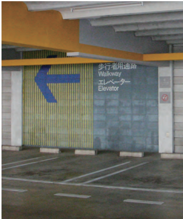
車室壁面案内表示（北棟 4F）
