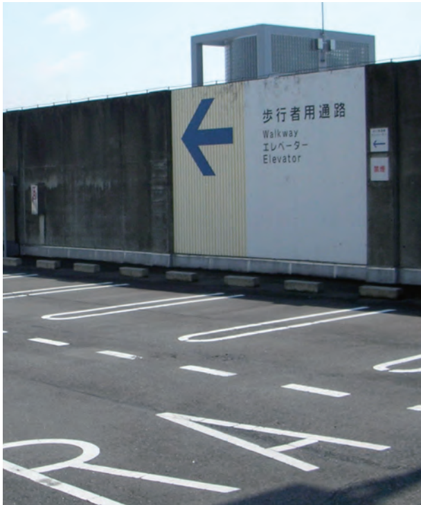
R階車室壁面（南棟）
