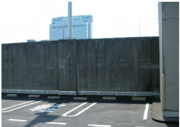
R 階壁面の案内表示（南棟）
