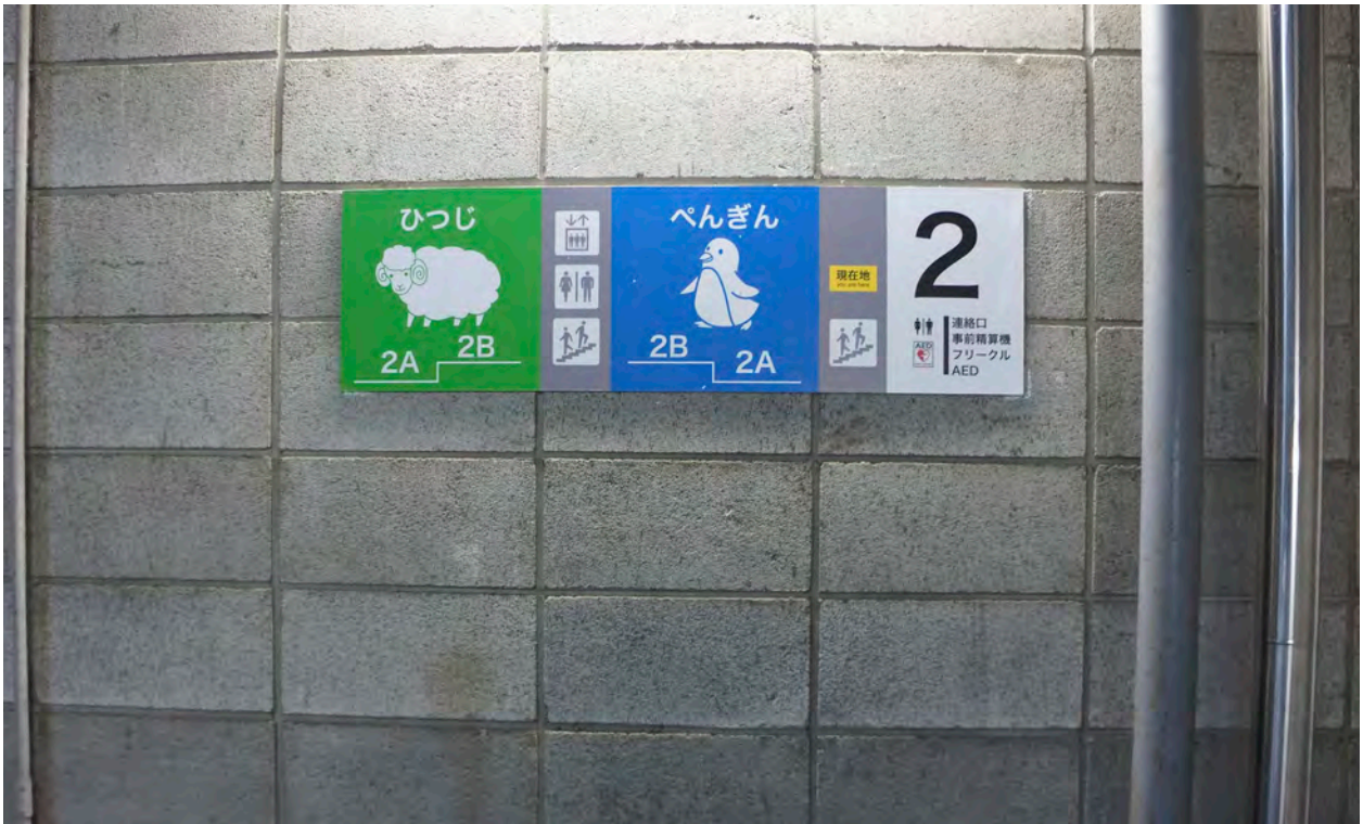
通路表示施工後 (2F)
