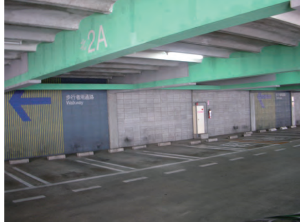
駐車場車室（北棟 2A）
