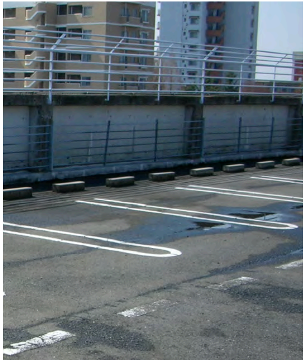
R階車室壁面（北棟）
