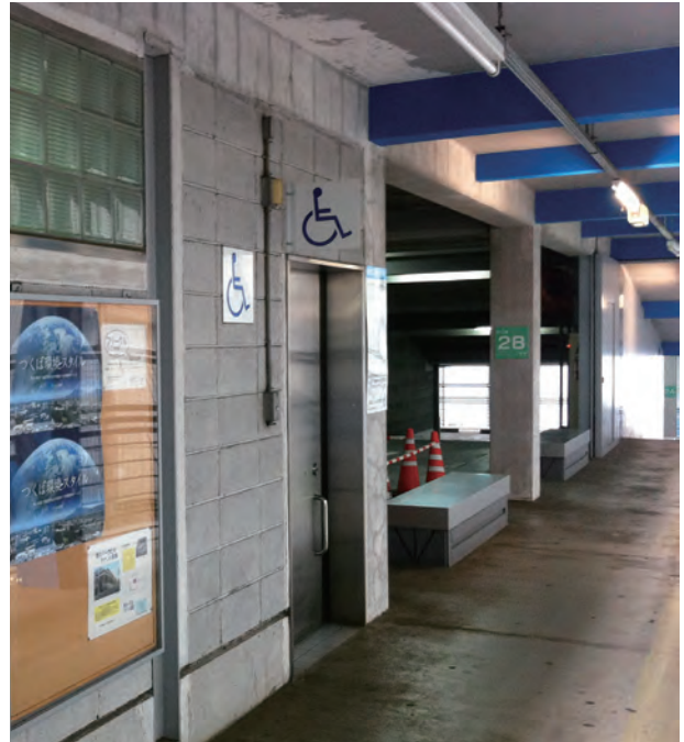
駐車場通路多目的トイレ前 (2F)
