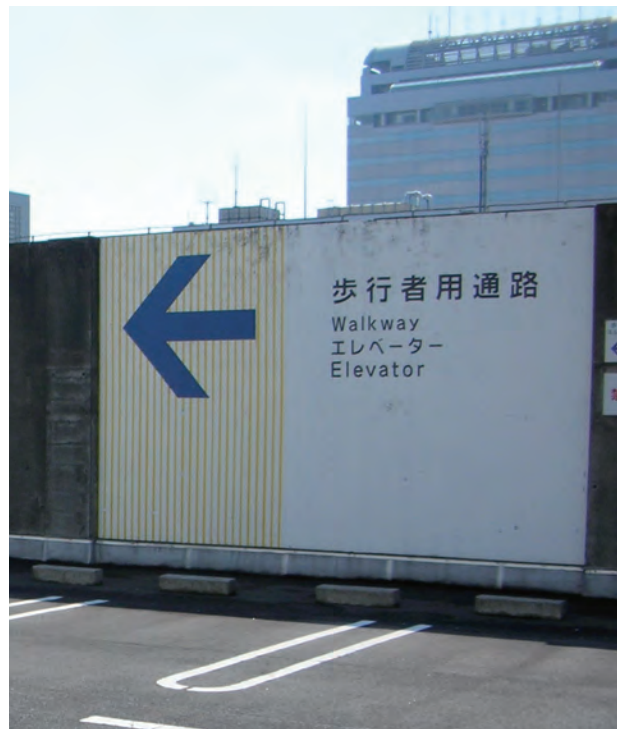
R 階車室壁面（南棟）
