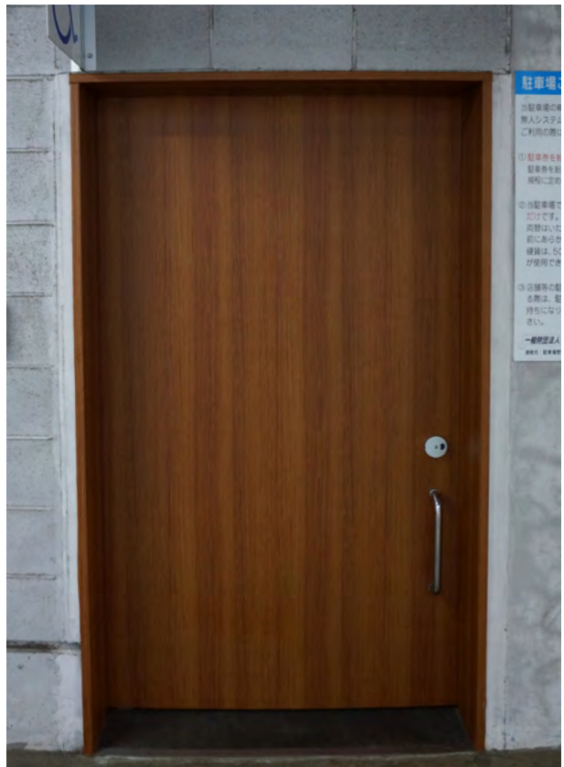
「みんなのトイレ」施工後（入り口）
