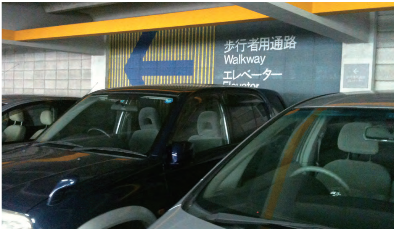
車室壁面 駐車車両あり（北棟 4A）
