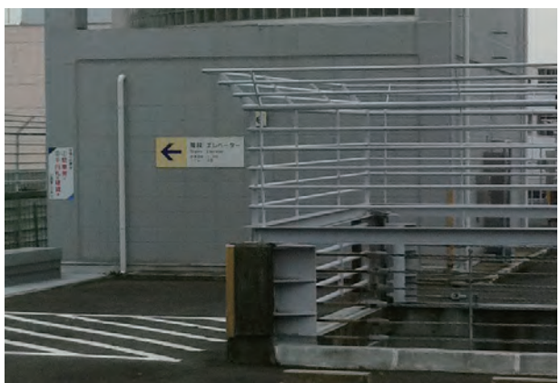
R 階エレベーターホール外側壁面の案内表示
