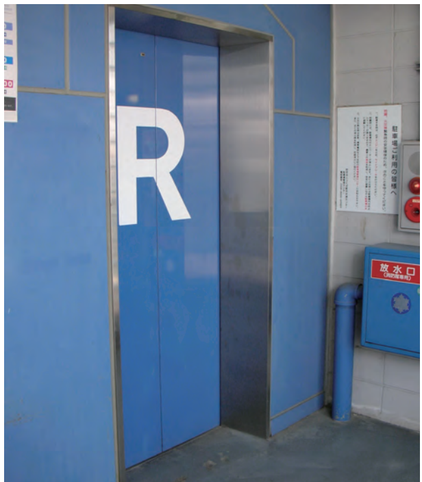
R階エレベーターホール
