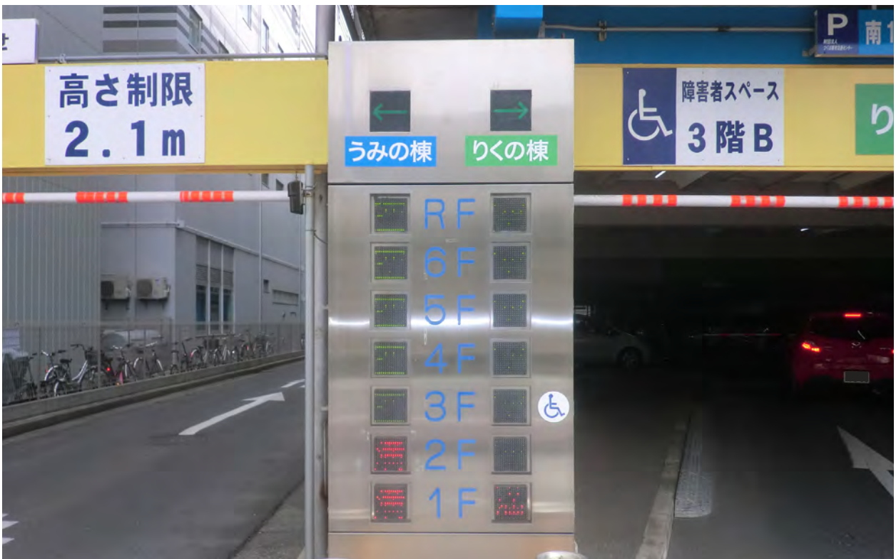
「りくの棟」「うみの棟」満空表示ロゴ施工後
