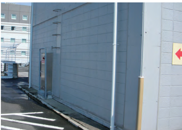
R 階エレベーターホール外側壁面の案内表示
