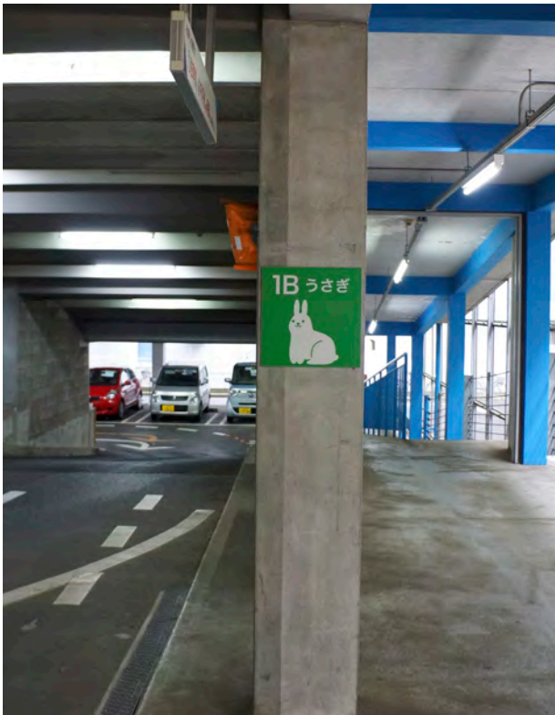
車室柱表示 (りくの棟 1B)
