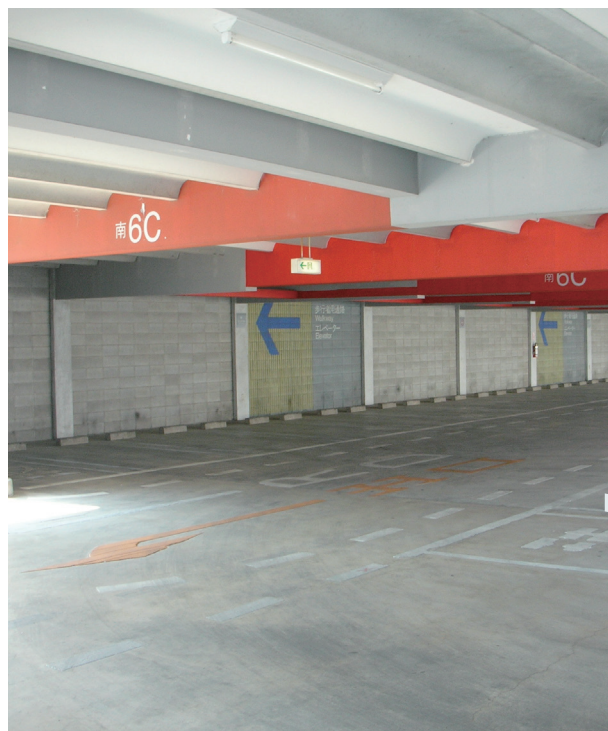
車室壁面案内表示（南棟 6F）
