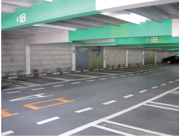
駐車場車室（北棟 1B）
