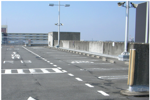
R 階壁面の案内表示（北棟）
