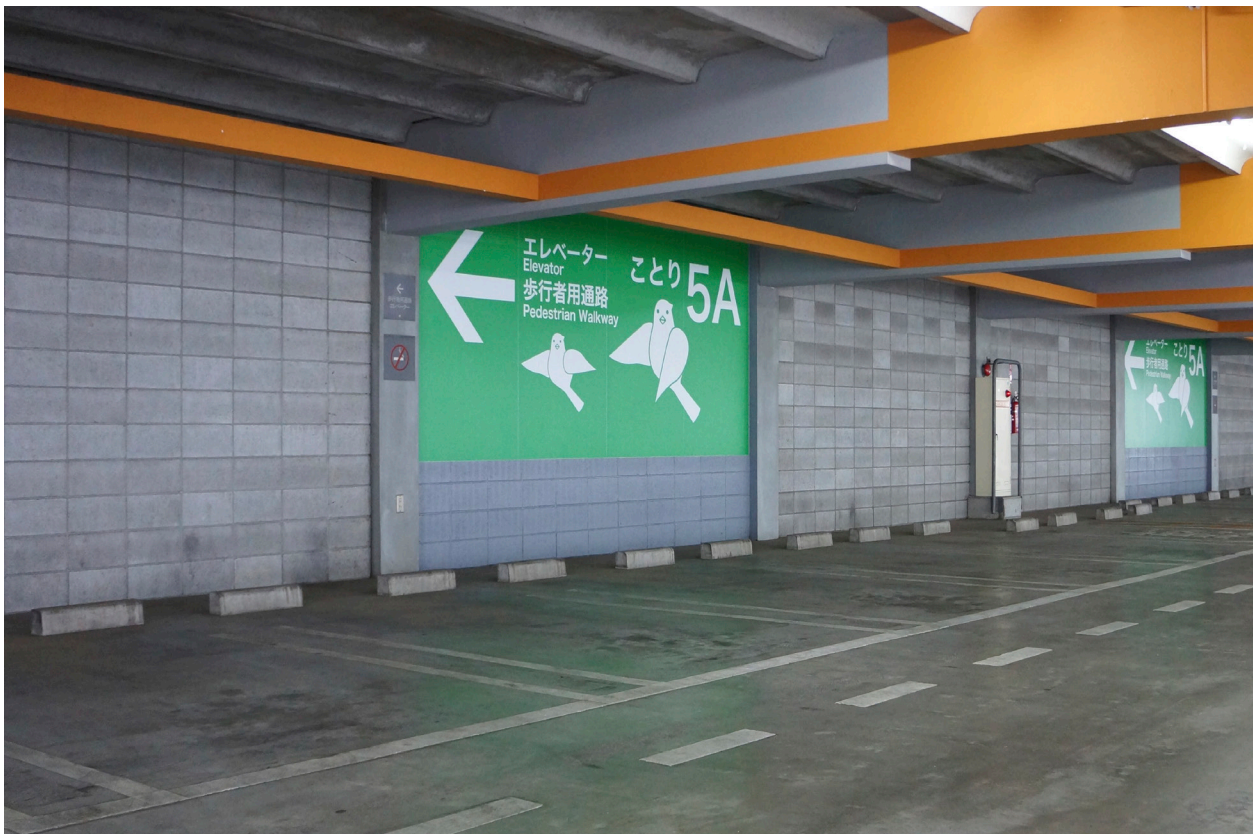
車室壁面（りくの棟 5A）
