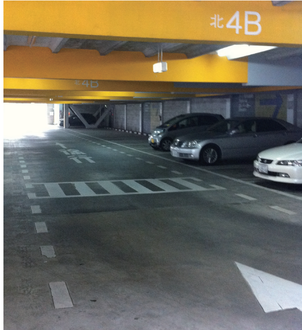
駐車場車室（南棟 4B）
