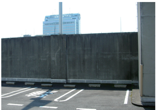
R 階壁面の案内表示（南棟）
