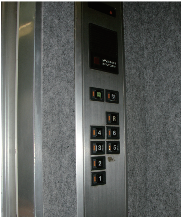
エレベーター行き先ボタン
