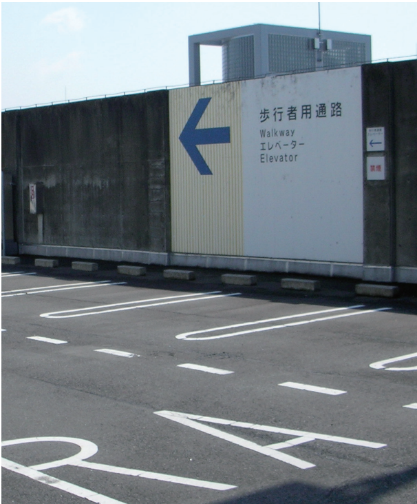
R階車室壁面（南棟）
