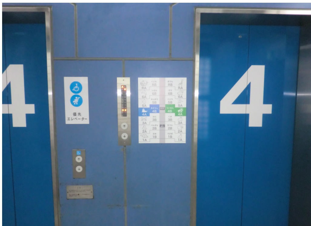
エレベーターホール（2F）
