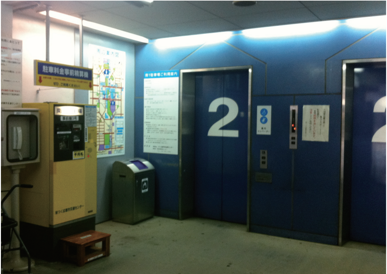
エレベーターホール (2F)
