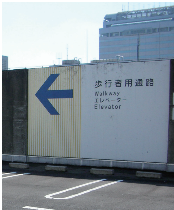
R 階車室壁面（南棟）
