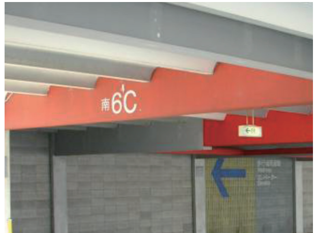
駐車場車室（南棟 6C）
