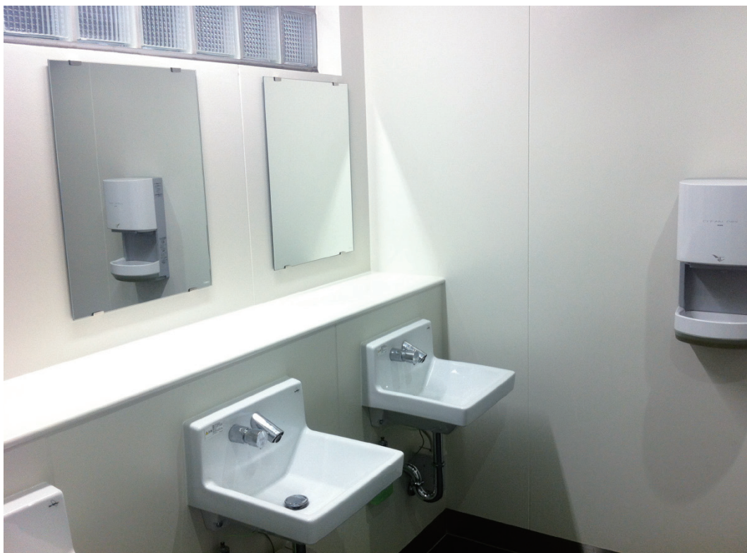
施工後トイレ（内部）
