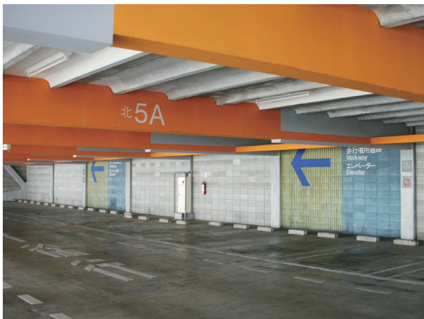
駐車場車室（南棟 5C）
