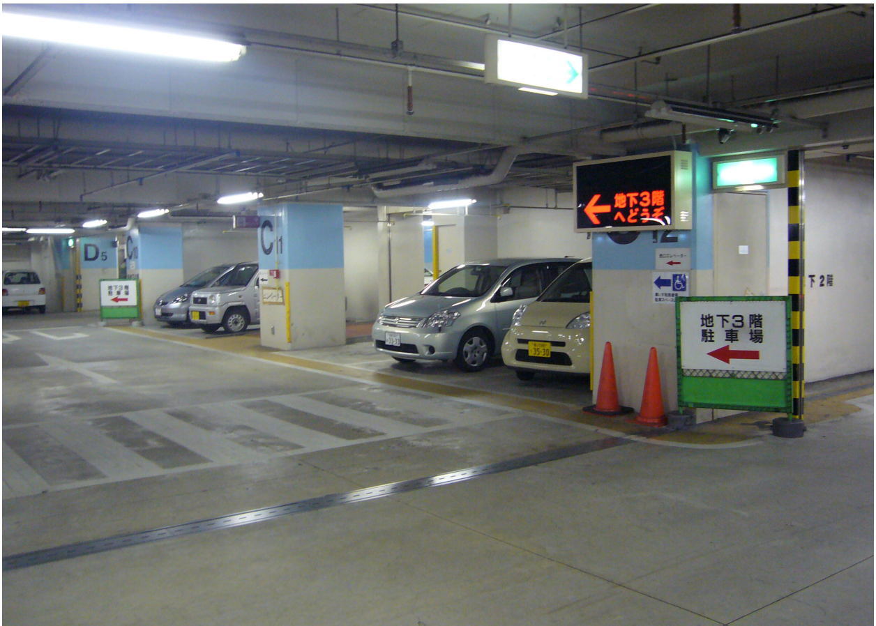
柱の上部にサインが表示されているため、車に遮られずに見やすい。
