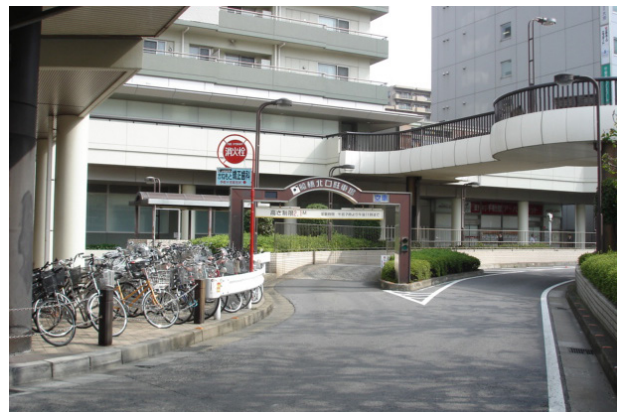
駅近くにある地下駐車場入口。
