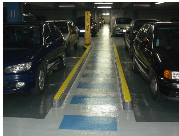
歩行者通路は色と仕切りで区切られている。
