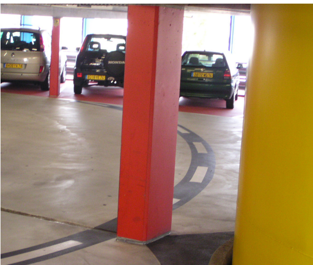
無塗装の車道にカラフルな柱が映える。
