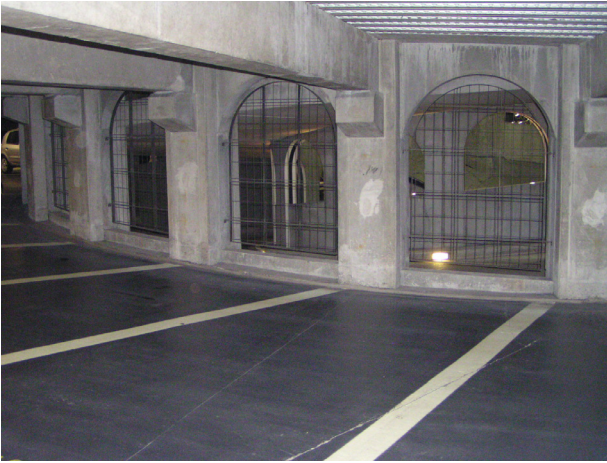
車路は連続スロープになっている。
