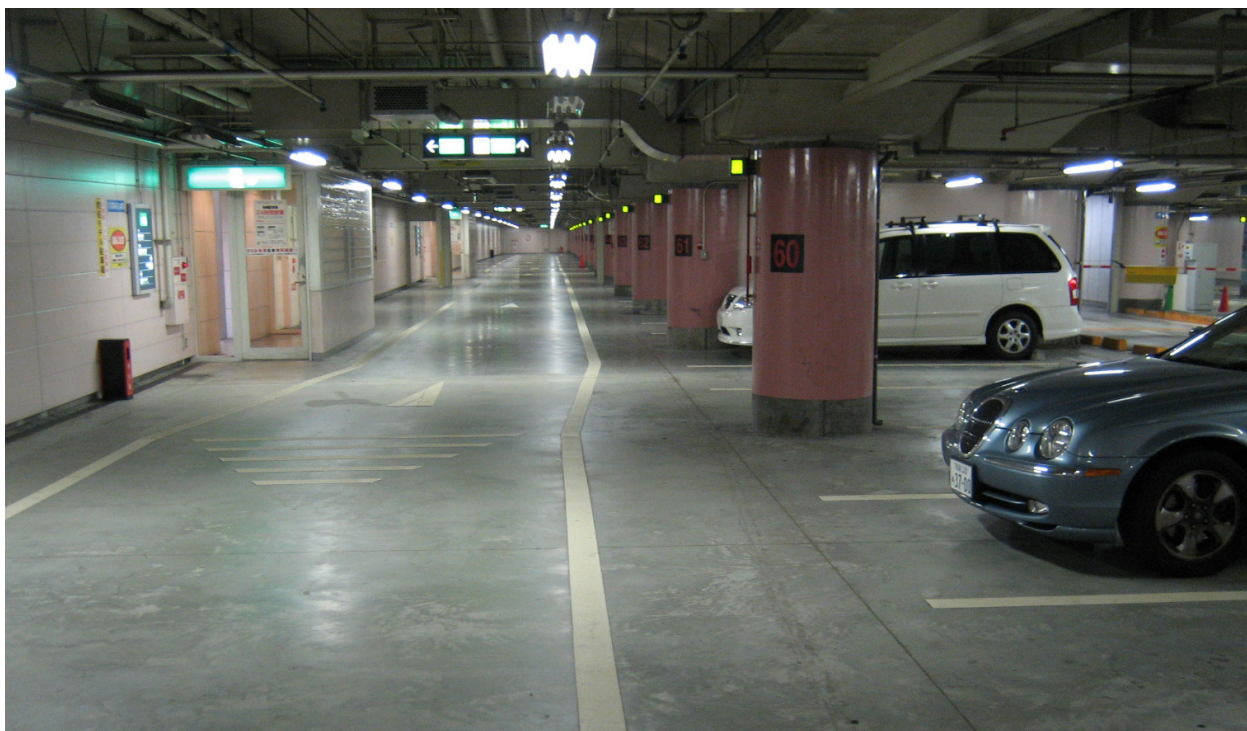
柱全体を色彩で塗装して、エリア分けを行っている。
