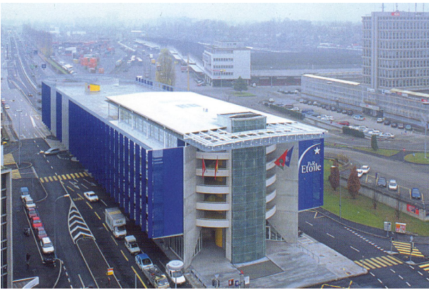
幹線道路上に立地する立体駐車場の全景。
