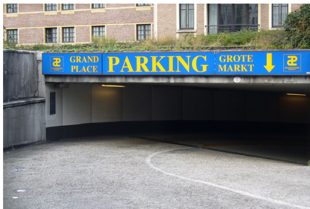
駐車場出入口の表示。青と黄色の配色。
