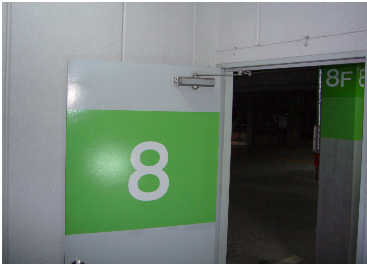
階段ホールから見たドア。大きなサインが設置されている。
